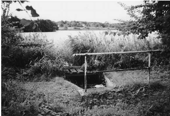
Die östliche Abflußstelle
